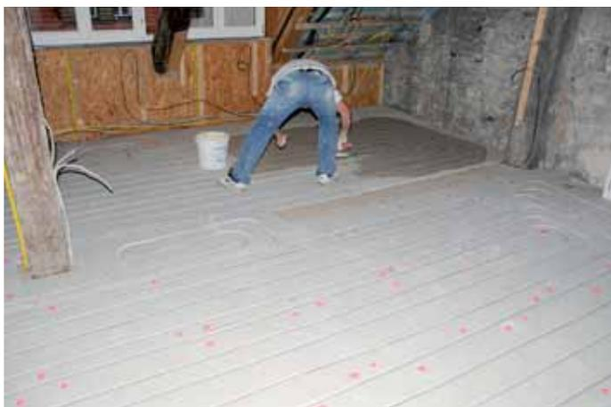
Nach Abschluss der Einfräs- und Verlegearbeiten werden die Knauf Trockenestrich-Elemente im Museum Ravensburger mit dem Nivellierspachtel F415 verspachtelt.
