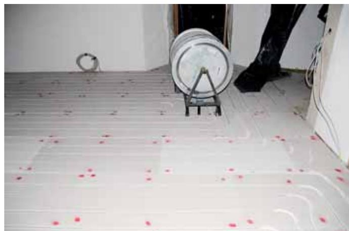
Vorteile entstehen auch bei der schnellen Verlegung des „JK Flextube“ Fußbodenheizungsrohres von der Rolle, das einfach mit dem Fuß in die entstandenen Einfräsungskanäle hineingedrückt wird.
