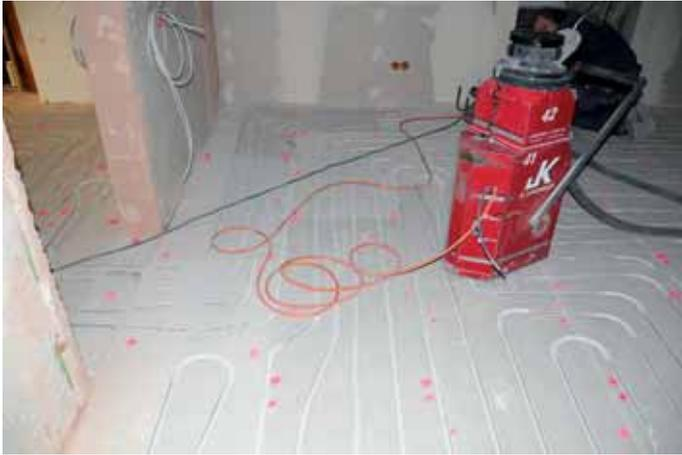
**Die revolutionäre und patentierte Einfräsmethode von JK ist auf vielen Estrichböden einsetzbar und ist nach Herstellerangaben dank effektiver Staubabsaugung völlig staubfrei. (Fotos: JK Fußbodenheizung GmbH)**
